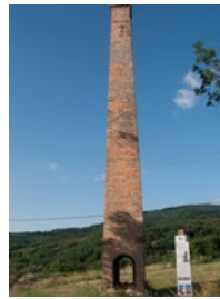
23. Cheminée d'usine à la base percée de deux ouvertures.
