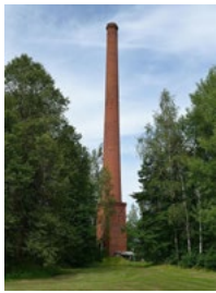
22. Cheminée d'usine à base parallélépipédique.
