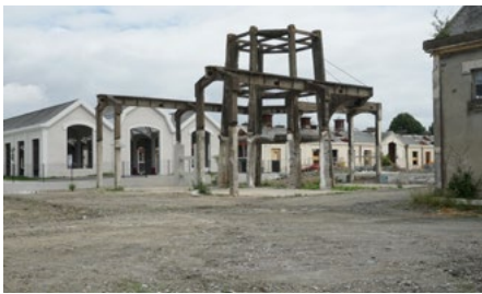
4. Socle du château d'eau de la manufacture des allumettes, Trélazé, Mai 2018.
