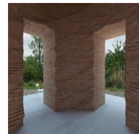
39. La Doublure , 2019 depuis l'intérieur de la nouvelle cheminée, 2,7m de diamètre, simulation ASBR
